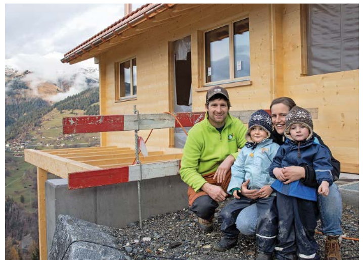
Das neue Wohnhaus von Familie Zumbrunn entsteht direkt neben dem Stall.
