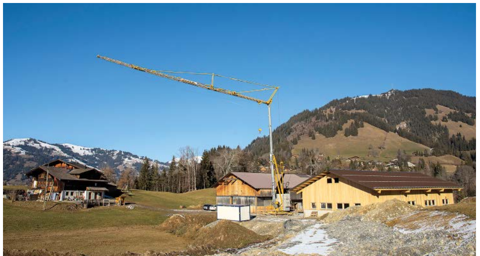
Der neue Stall liegt direkt neben dem alten Ökonomiegebäude, das Bruno weiterhin als Remise und allenfalls auch für agrotouristische Zwecke nutzen will.
